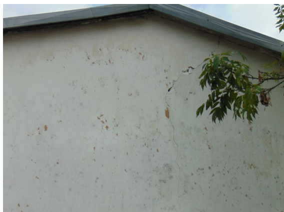
2. Widoczne pęknięcia muru ściany zachodniej w rejonie stropodachu
