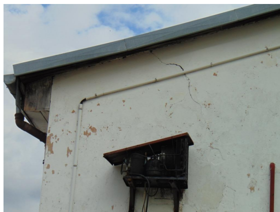
2. Widoczne pęknięcia muru ściany zachodniej w rejonie stropodachu
