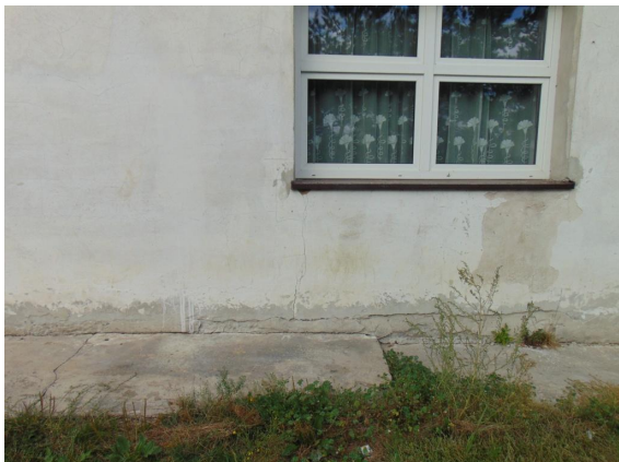
3. Widoczne pęknięcia muru ściany południowej pod oknami oraz odpadające tynki
