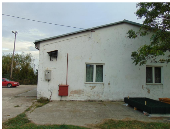
4. Zmiany tynków w strefie przyziemia spowodowane zawilgoceniem murów
