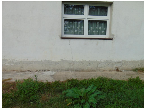
3. Widoczne pęknięcia muru ściany południowej pod oknami oraz odpadające tynki
