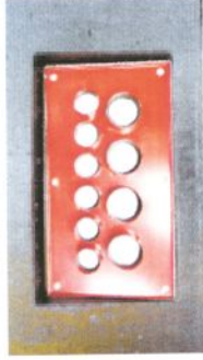
Przepusty nN (Widok z wnętrza, od strony gruntu rodzimego)
